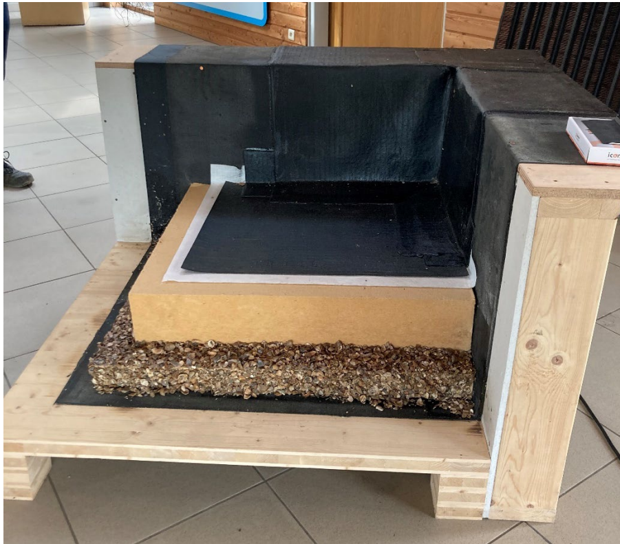
Figuur 13: Mock-up circulaire dakopbouw 't Centrum Kamp C. Uiteindelijk werd de dakopbouw anders uitgevoerd door aannemer Beneens. Zo bleek het bio-based materiaal dat voorzien was voor het afschot in de praktijk niet werkbaar voor deze toepassing. Men heeft uiteindelijk gerecupereerde OSB-platen gebruikt om het afschot te maken.
