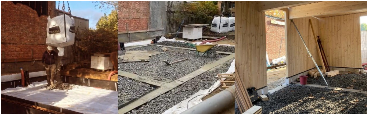
Figuur 9: Toepassing van gerecycleerde glasschuimgranulaten bij het project CBBW door TEKEN architectuur (bron: tijdschrift CBBW)
