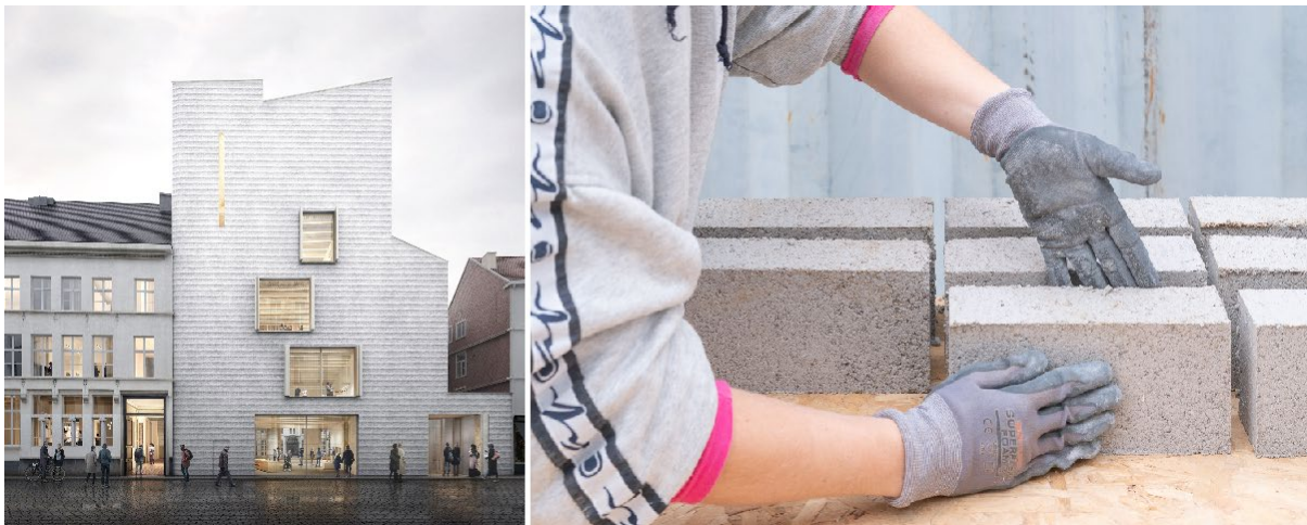
Figuur 10: Ding Museum met circulaire gevelsteen. De steen wordt gemaakt van afvalstromen uit de stad, waaronder fijngemalen beton en wit glas. © Cinzia Romanin & Thomas Noceto, bron Circubuild
