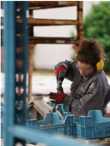
1) Illustratie van de principes van hergebruik aan de hand van een tegelvloer: zorgvuldige demontage, vervoer, reiniging, verpakking en hermontage.
