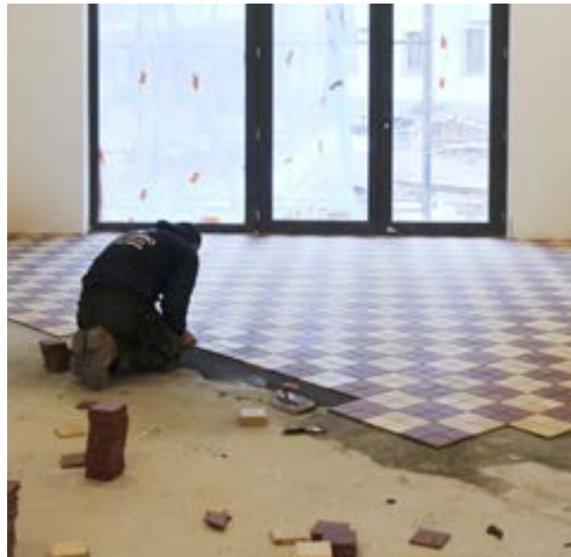
1) Illustratie van de principes van hergebruik aan de hand van een tegelvloer: zorgvuldige demontage, vervoer, reiniging, verpakking en hermontage.
